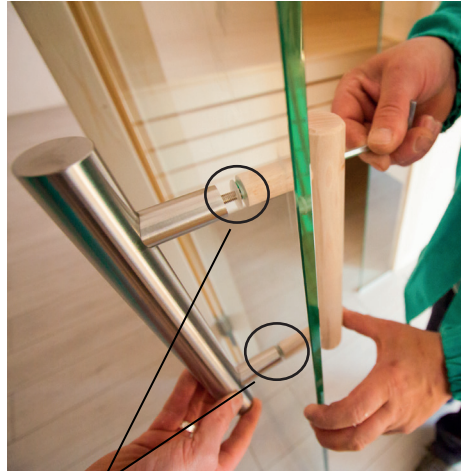
Inserir as anilhas planas de plástico no puxador de aço inoxidável
